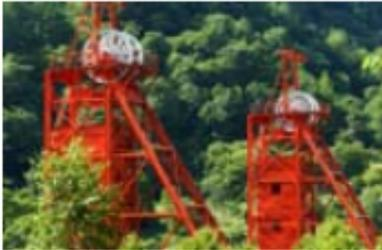
立坑とは、石炭や人員、ズリまたは貨物を運搬するために掘削された縦穴であり、空気を入れる入気立坑と、排気を行う排気立坑を設けるのが一般的である。立坑櫓は、立坑の上部に設置される櫓のことで、ここに滑車とロープを掛け、巻き上げ機で運搬を行っていた。
